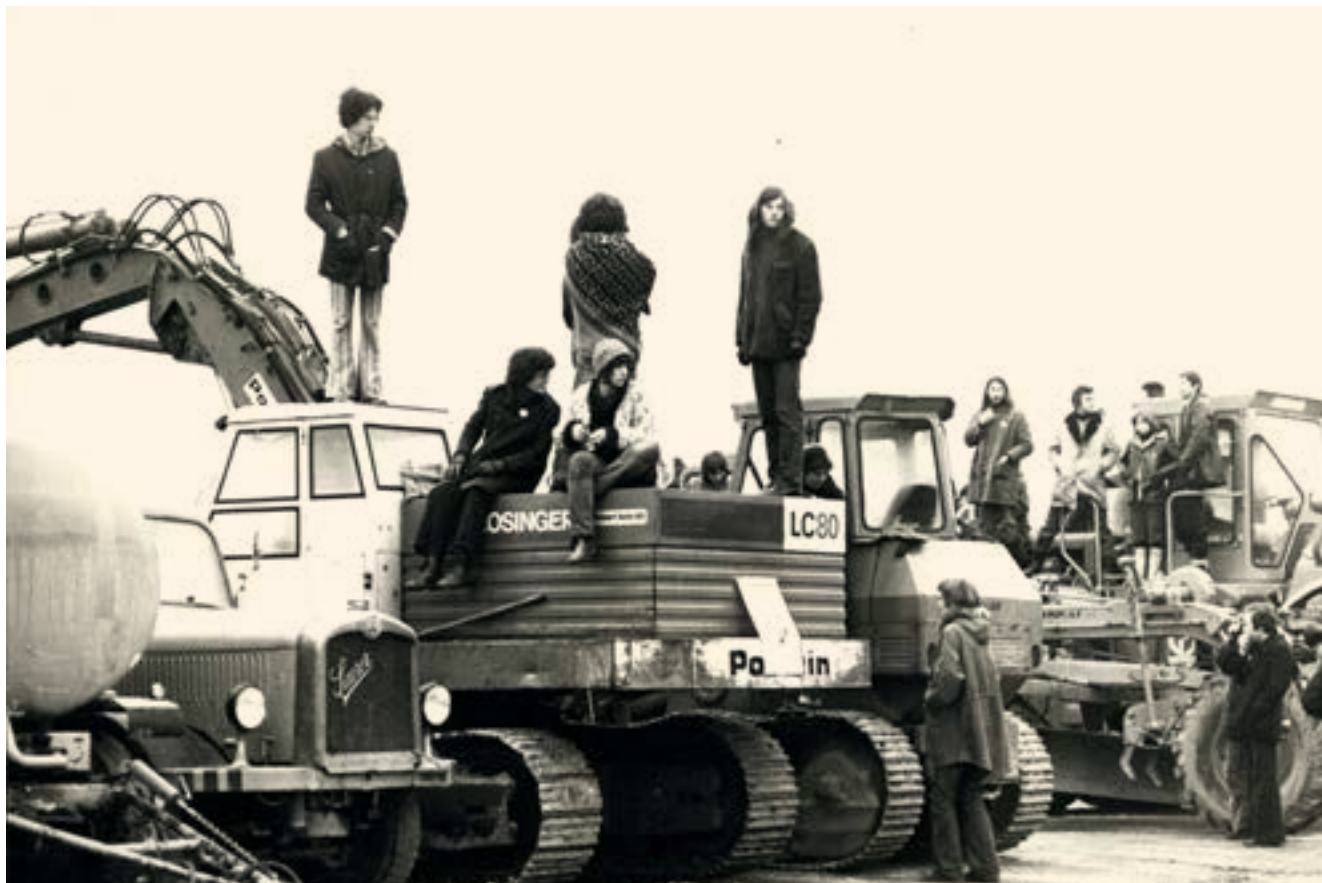
2 avril 1975, occupation du chantier de la centrale de Kaiseraugst. Photos: Alamy (haut), Musée national suisse (bas).
