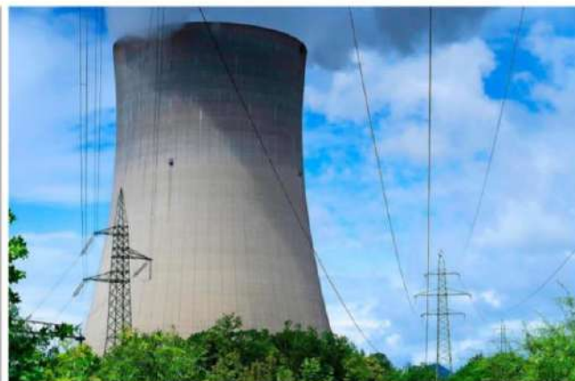
La Suisse compte cinq centrales nucléaires. Ici, celle de Gösgen (SO). HEYSTONE
