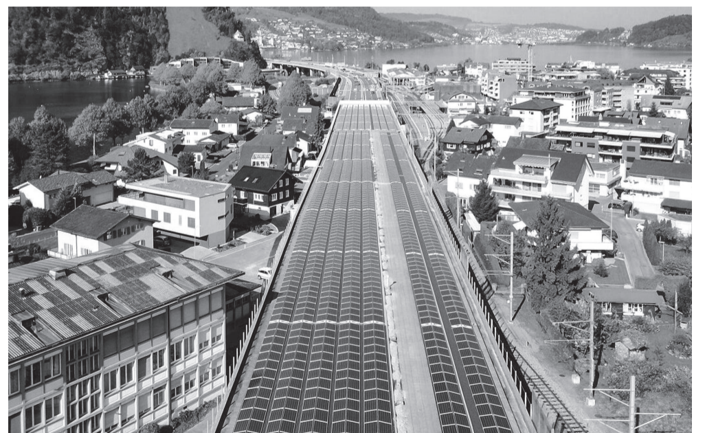
Voies de train recouvertes de panneaux solaires à Stansstad près de Lucerne.
