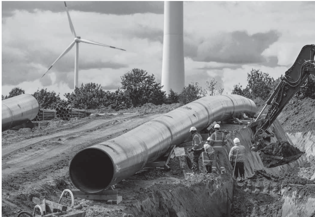
Gaz russe ou renouvelable européen ? Ici, le chantier du gazoduc Eugal prévu pour relier la Russie à la Tchéquie. © Greenpeace
