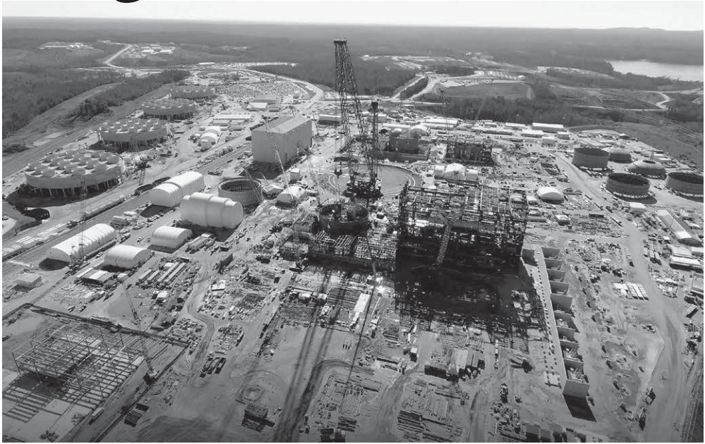
Chantier du projet de centrale V.C. Summer en Caroline du Sud récemment abandonné pour raison de surcoûts. Photo: South Carolina Electric & Gas
