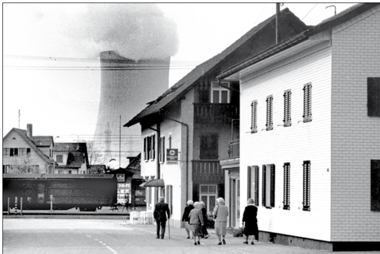
Centrale nucléaire de Gösgen, canton de Soleure Photo (jjkphoto.ch)
